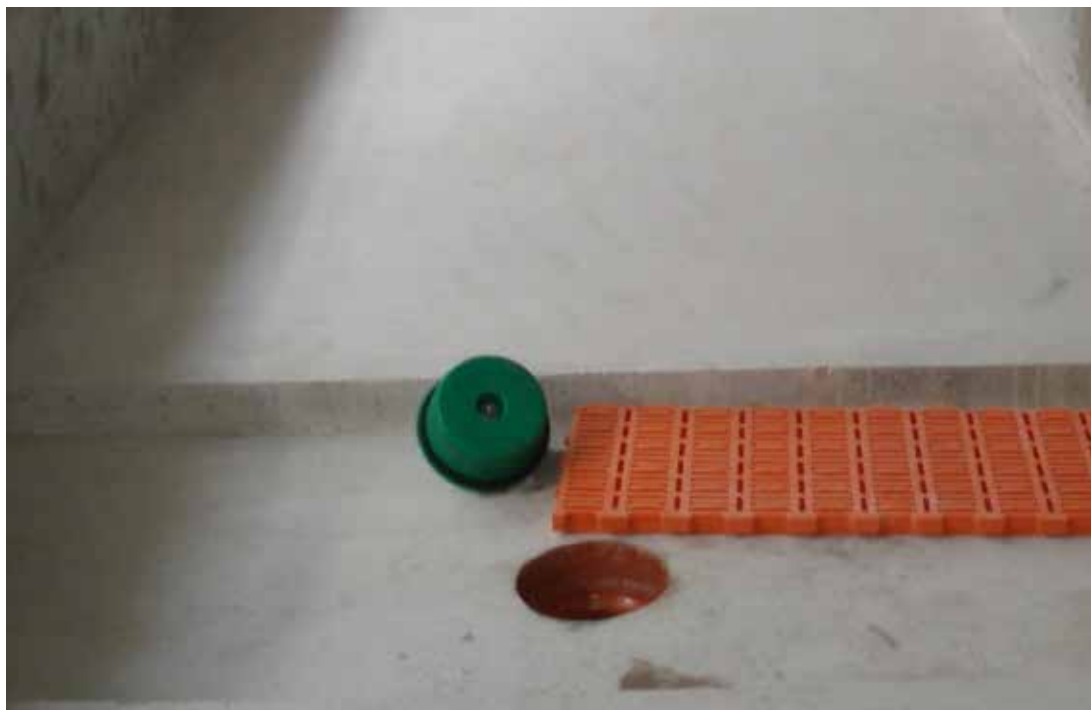
Фото №1: Очистка сливной горловины и герметизирующей пробки
