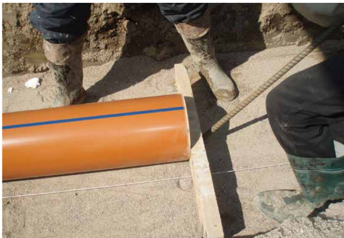
Фото № 4: Процесс вдавливания одной трубы в другую
