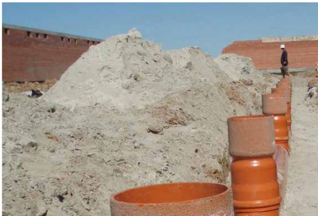
Фото № 17: Монтаж удлинителей сливных горловин
