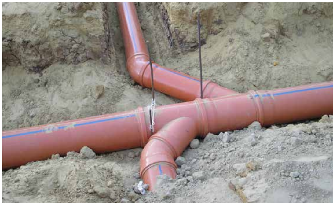
Фото № 21: Соединение секционных труб с трубой центрального сборного коллектора
