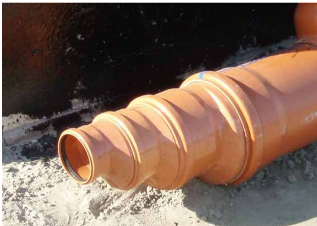
Фото № 18: Монтаж переходного клапана и отводной трубы воздушного клапана
