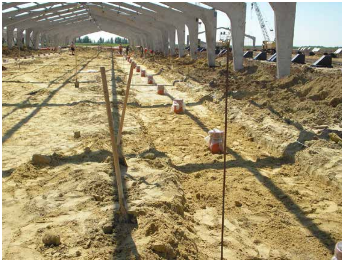
Фото № 16: Окончательная засыпка трубы песком с последующим уплотнением
