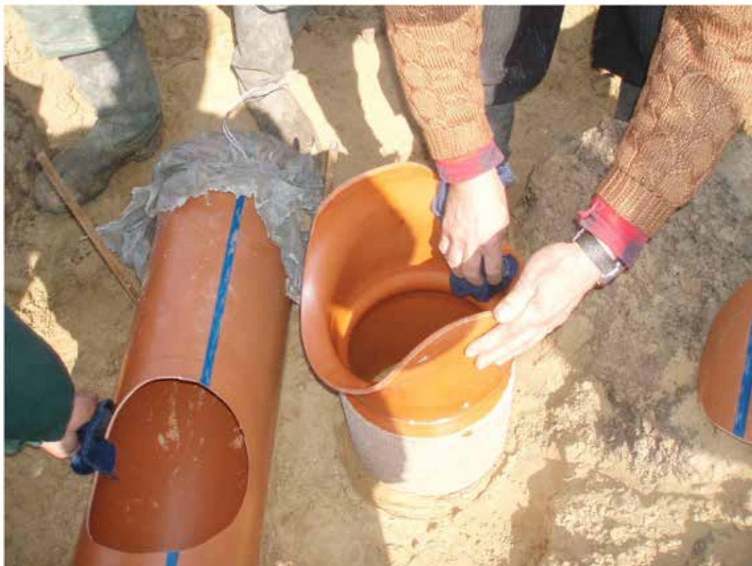
Фото № 9: Обезжиривание поверхности горловины и трубы
