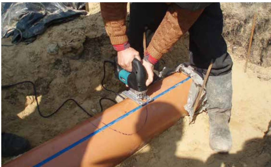
Фото № 8: Вырезание отверстий в трубе электрическим лобзиком
