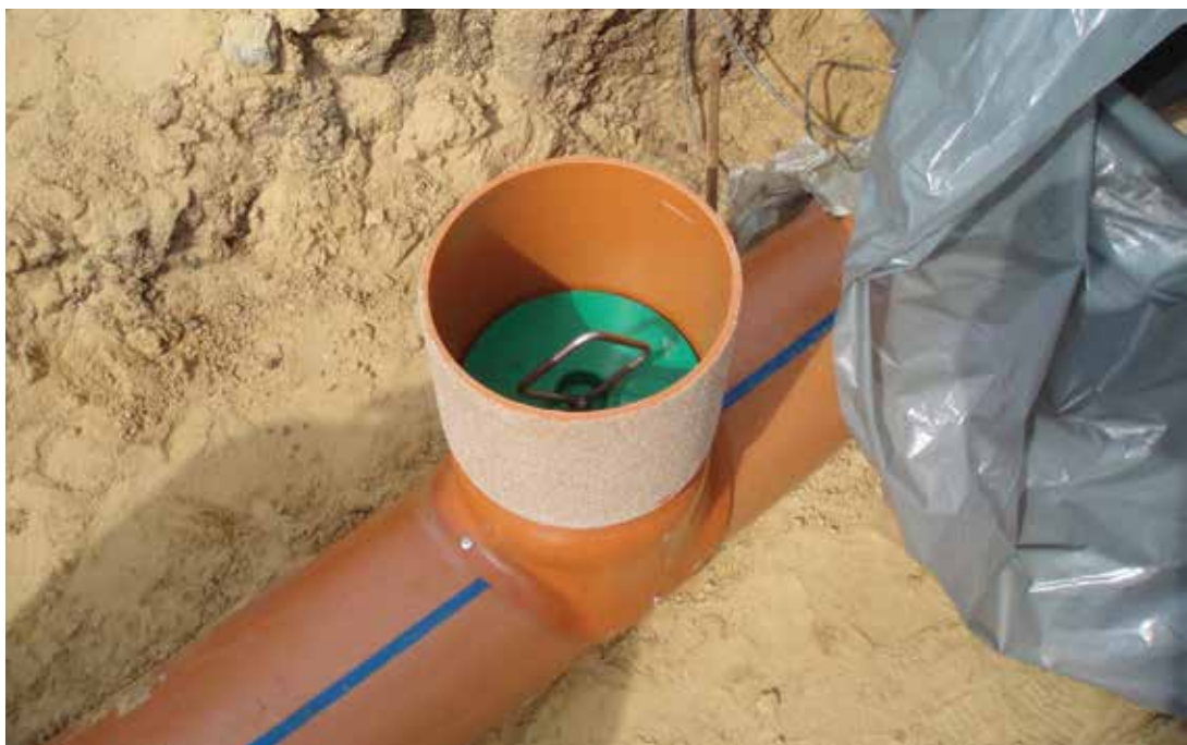
Фото № 13: Установка герметизирующей пробки в сливную горловину
