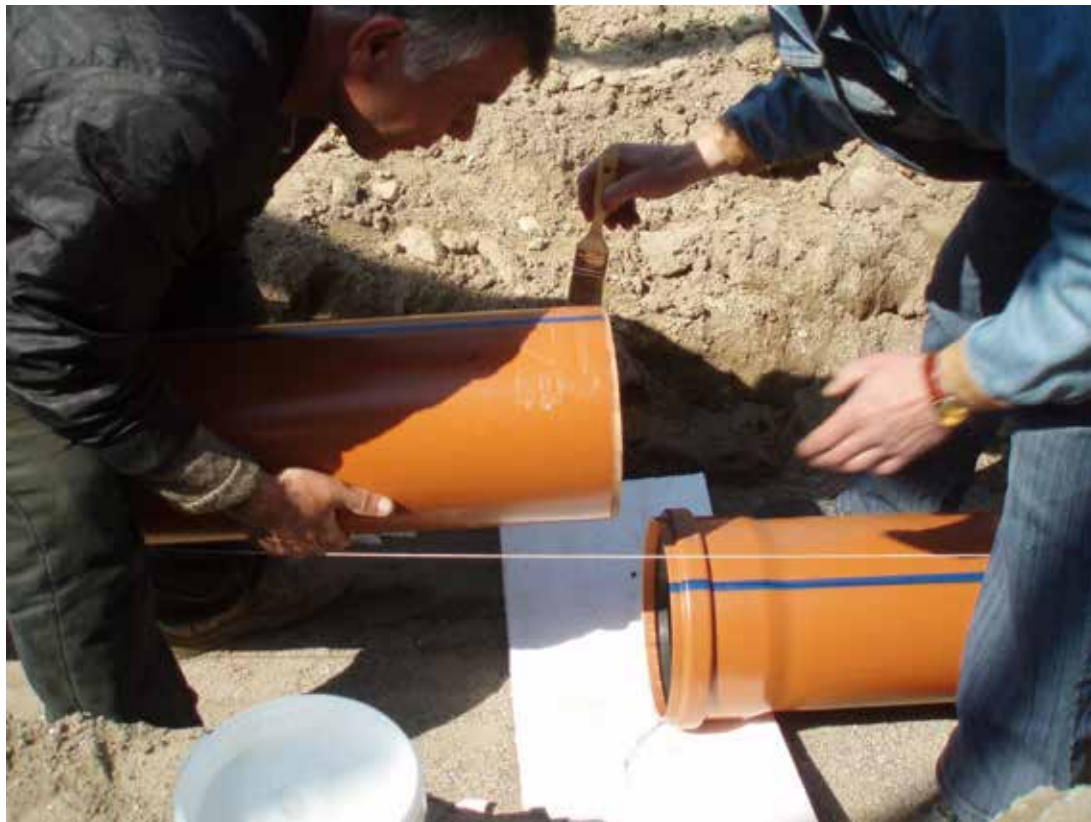
Фото № 2: Нанесение смазывающего состава на поверхность трубы
