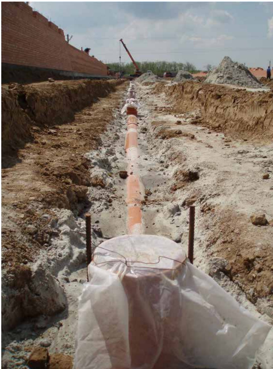
Фото № 15: Фиксация линии трубы увлажненным песком
