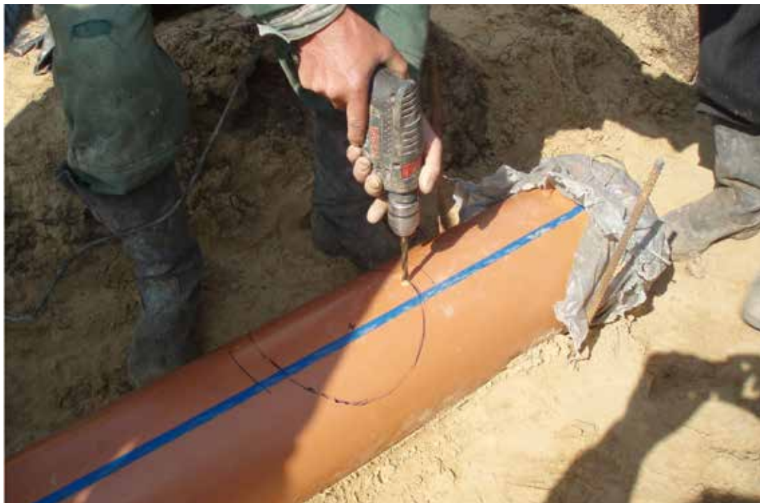
Фото № 7: Границы вырезаемых площадей, подготовка к вырезанию отверстий
