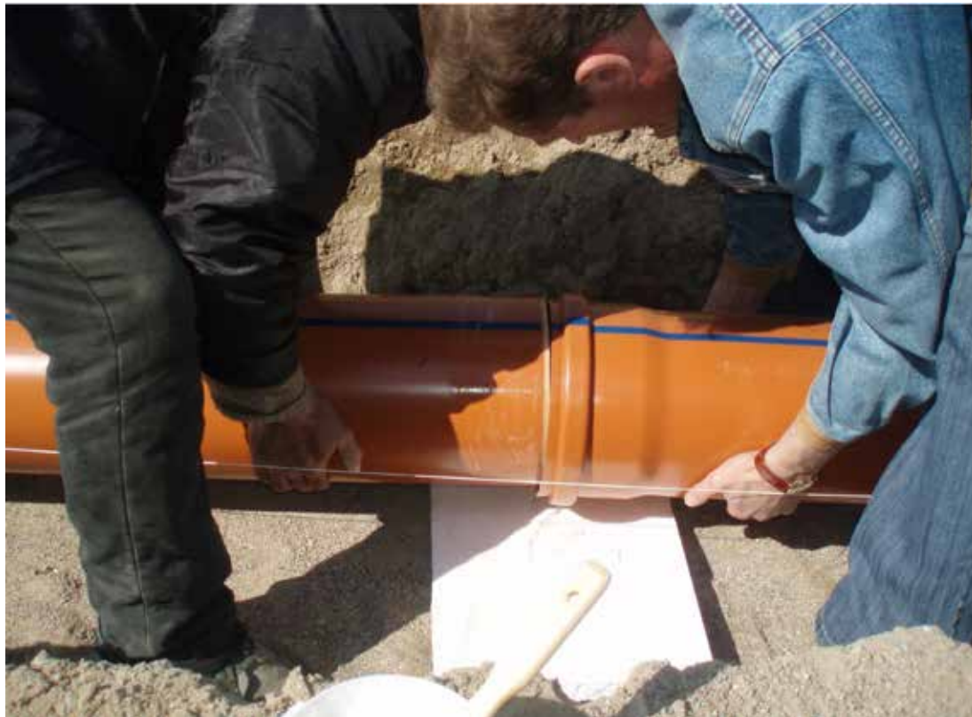
Фото № 3: Процесс стыковки двух труб системы навозоудаления
