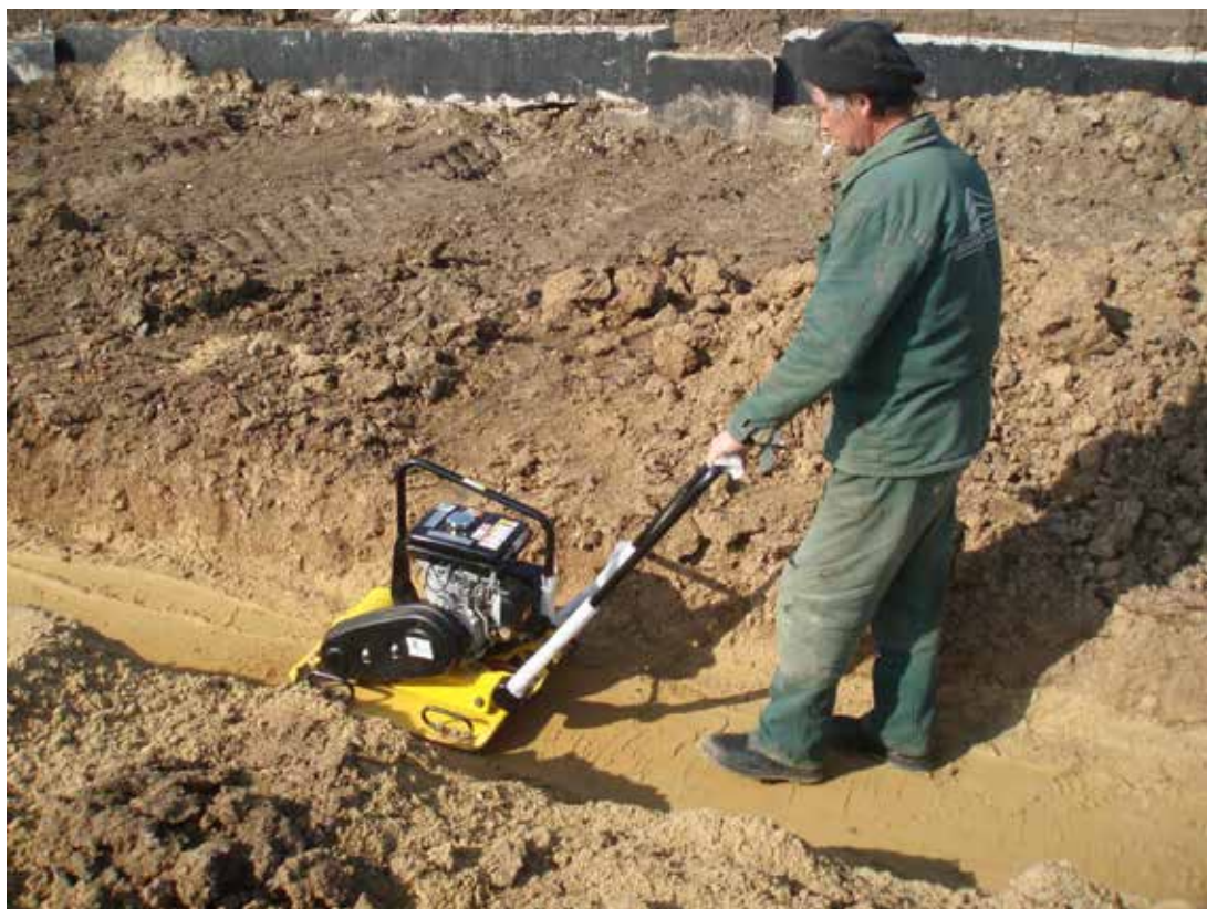
Фото № 1: Уплотнение основания траншеи
