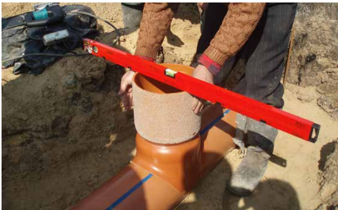
Фото № 11: Юстировка сливной горловины рейкой водяного уровня
