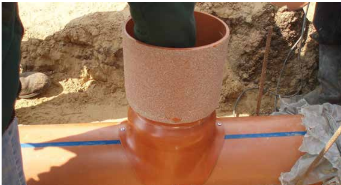
Фото № 12: Фиксация сливной горловины шурупами
