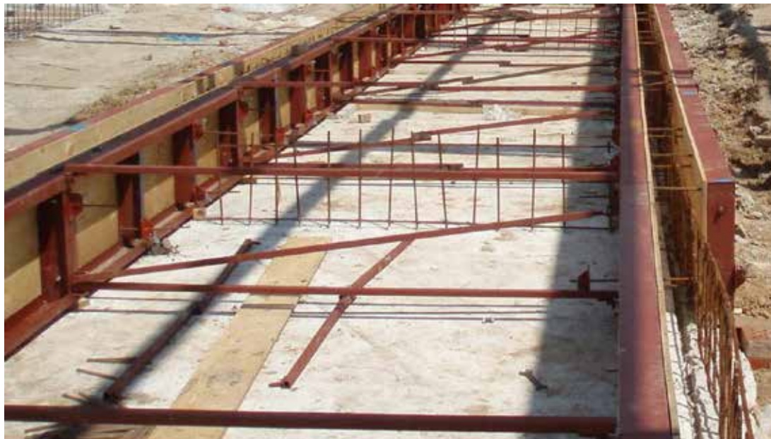
Фото № 7: Изготовление арматурного каркаса и установка опалубки
