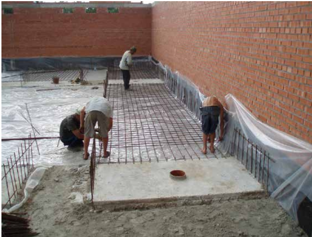
Фото № 5: Изготовление арматурного каркаса бетонного днища ванны
