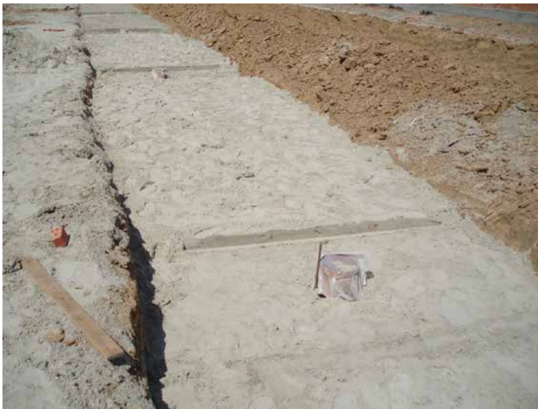
Фото № 1: Обустройство песчаной подготовки толщиной 100 мм.
