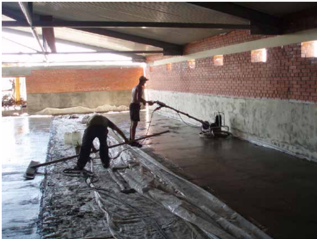
Фото № 12: Обработка поверхности бетонных полов
