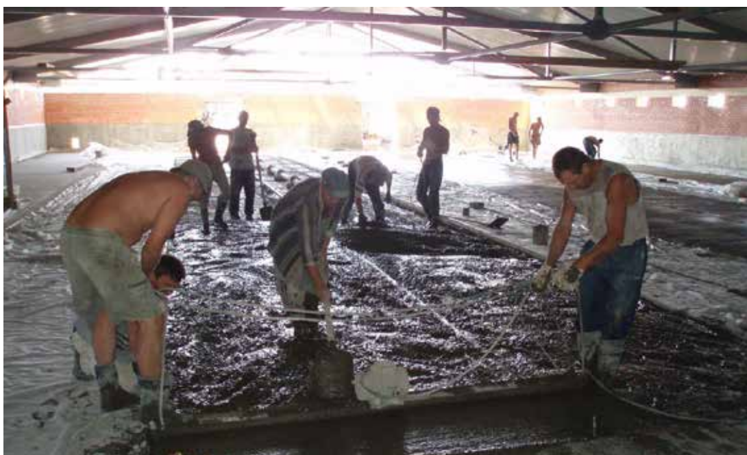
Фото № 11: Изготовление бетонных полов с двусторонним уклоном
