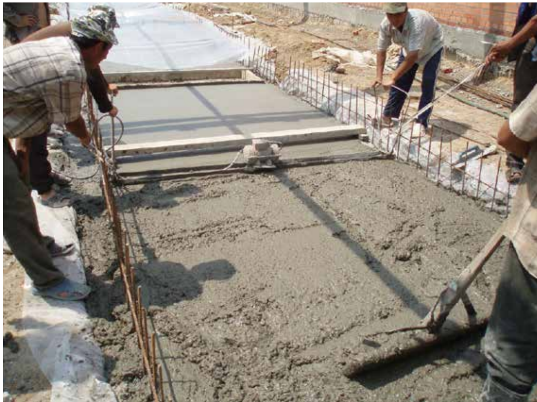
Фото № 6: Изготовление бетонного днища навозонакопительной ванны
