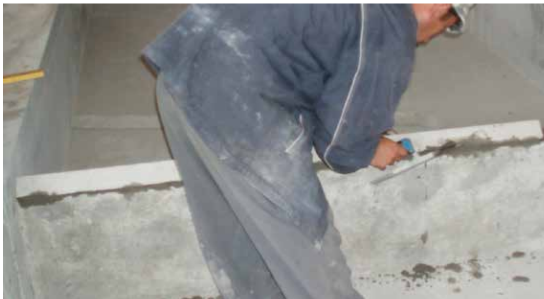
Фото № 8: Изготовление бетонного разделителя навозонакопительной ванны
