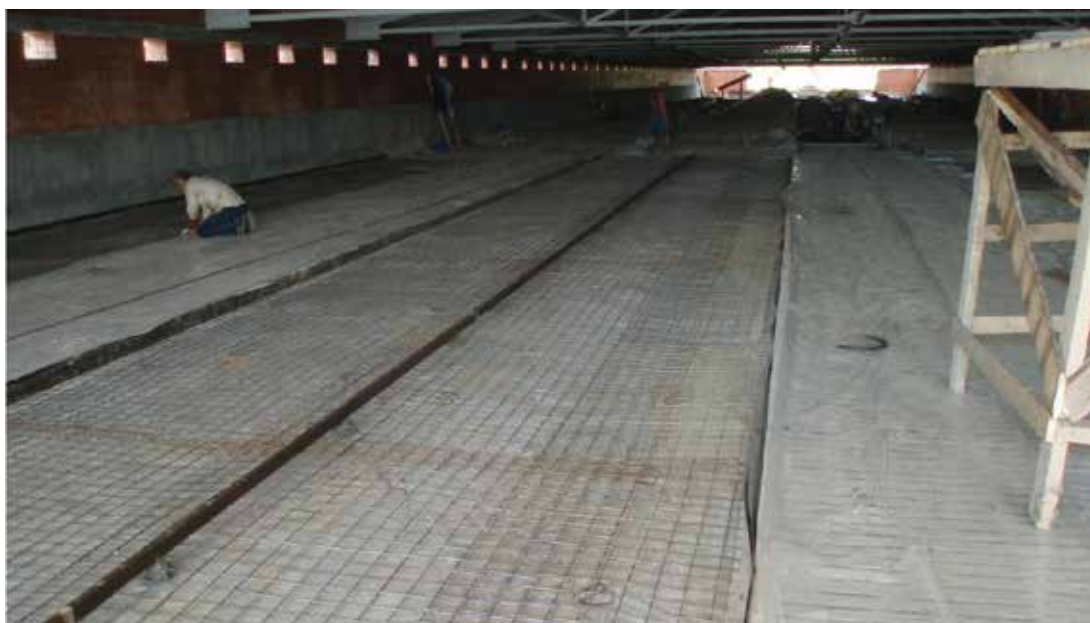
Фото № 10: Укладка арматурного каркаса и обустройство двустороннего уклона
