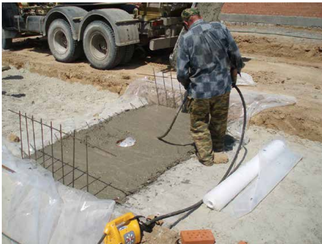
Фото № 4: Изготовление бетонного приемка навозонакопительной ванны
