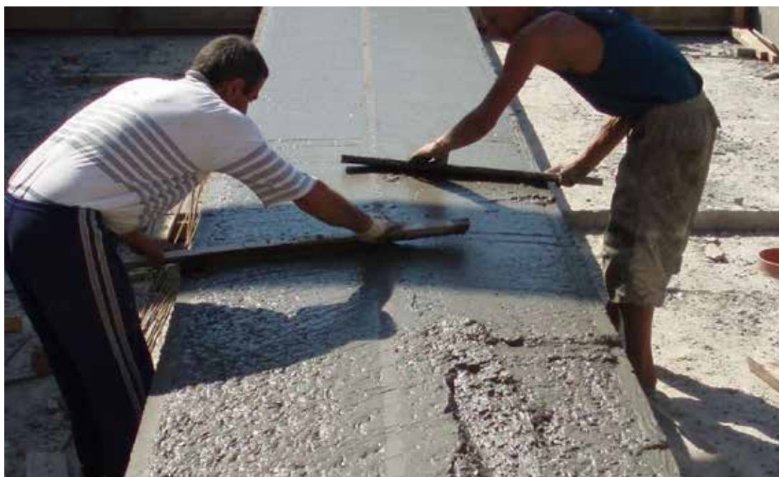
Фото № 9: Изготовление бетонных проходов с двусторонним уклоном
