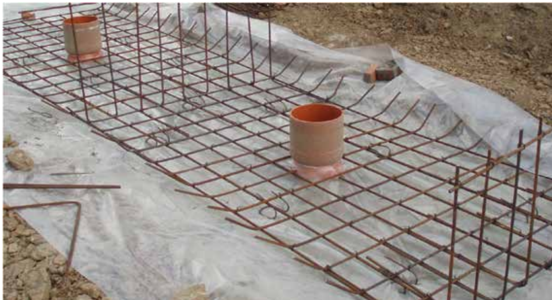
Фото № 3: Обустройство гидроизоляционного слоя и арматурного каркаса
