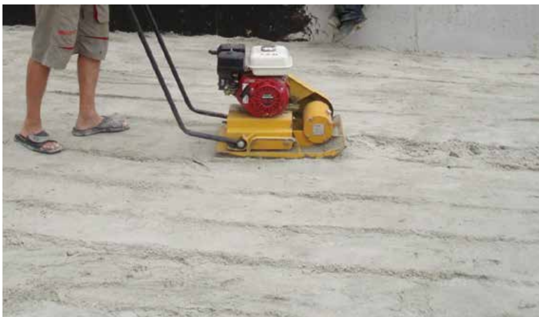
Фото № 2: Уплотнение песчаного основания вибрационной плитой
